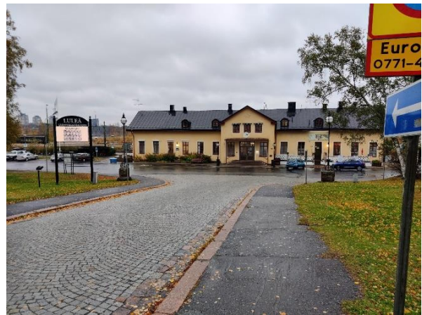
Figur 22. Luleå centralstation, stationsbyggnad.
