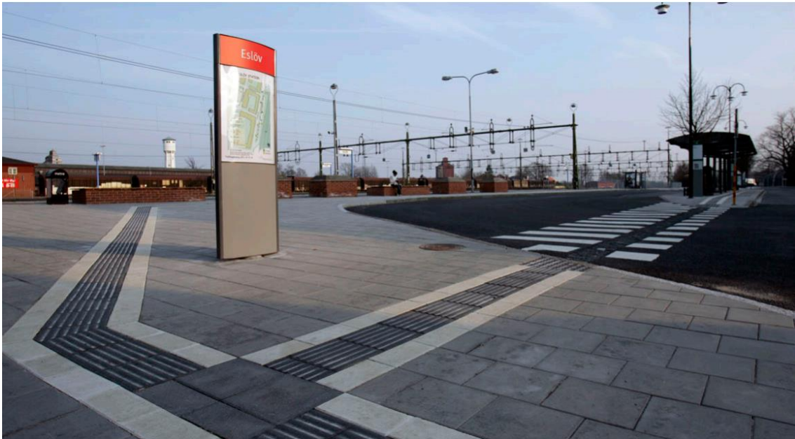
Figur 55. Exempel på taktill markbeläggning och kontrastmarkering som bildar tydliga ledstråk (Trafikverket, 2017).
