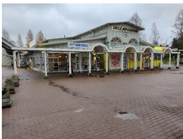
Figur 26. Luleå busstation, stationsbyggnad.
