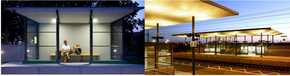
Figur 59. Vällibelysta klimatskydd och plattformstak (Trafikverket, 2017).
