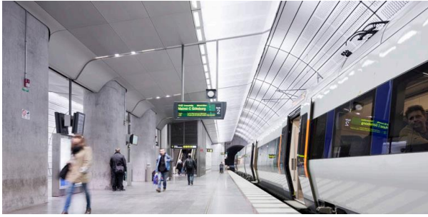
Figur 42. Bra belysning vid underjordisk plattform i Malmö (Trafikverket, 2017).
