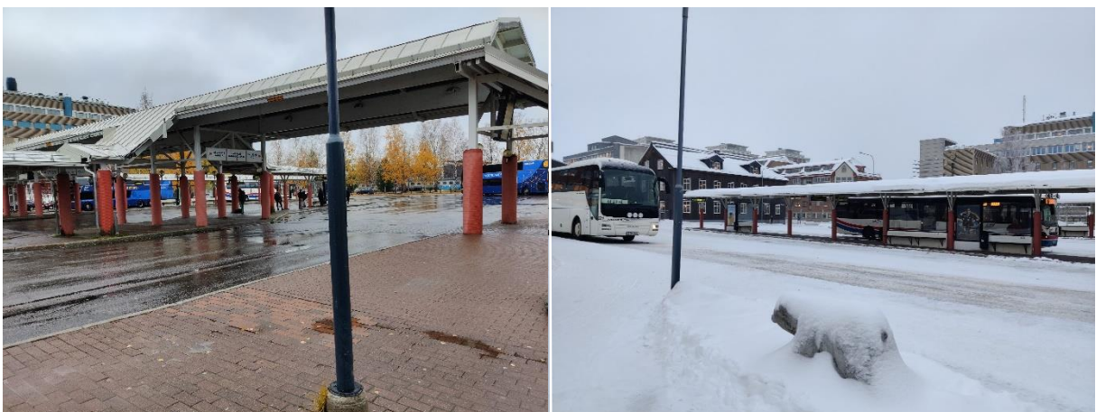
Figur 30. Luleå busstation, uppställningsyta för bussar.
