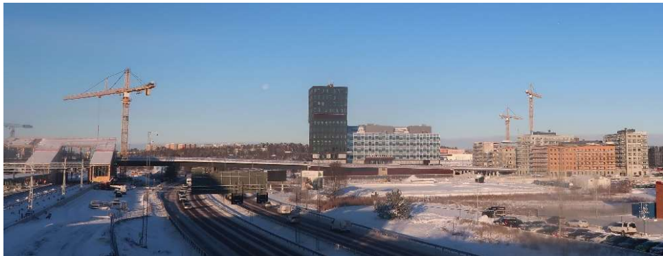
Figur 2: Vy över Barkarbystaden från östra pendeltågsingången, pågående bygget av västra nedgången till vänster i bild och E18 som sträcker sig under Veddestabron. I mitten mörk- och ljusgråa Bas Barkarby.
